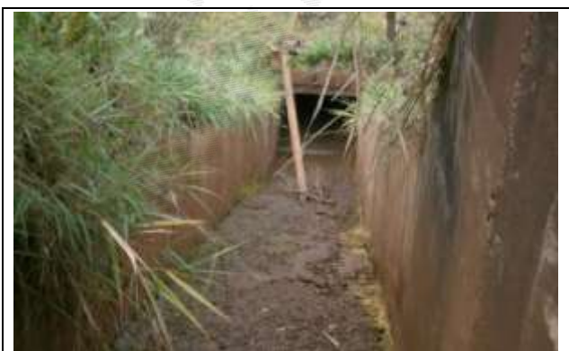
Foto 11 – Emboque do segundo trecho da galeria de fundo, com tubulação em desuso podendo causar obstrução.
