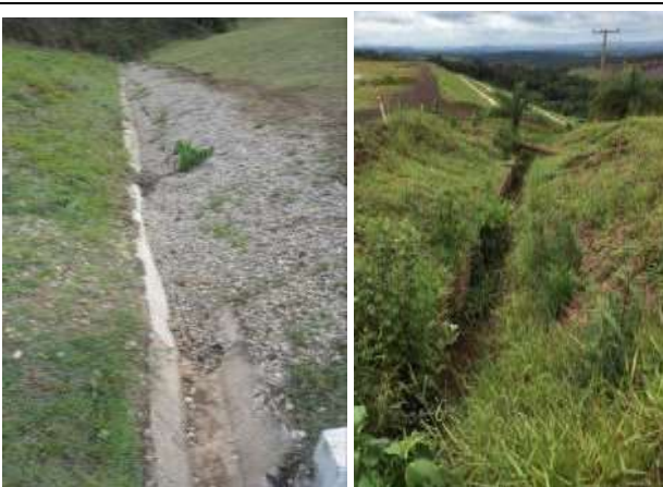
Foto 6 – Trechos de canaletas de drenagem obstruídos por brita e vegetação.
