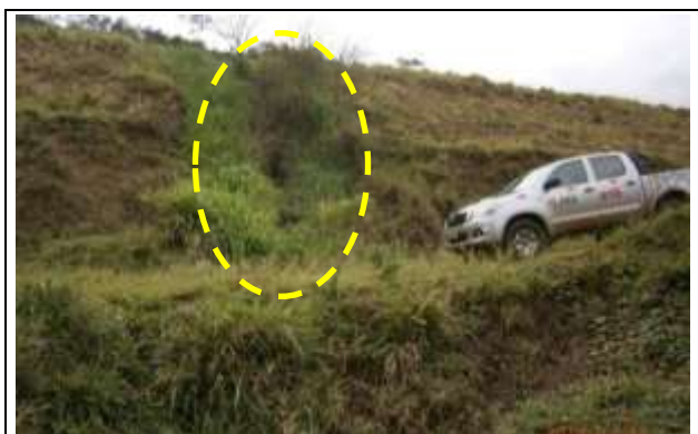
Foto 12 – Desemboque da segunda galeria extravasora e descida em degraus encoberta por vegetação.
