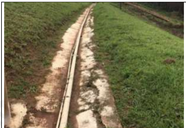
Foto 8 – Canaleta de drenagem superficial com danos no concreto.
