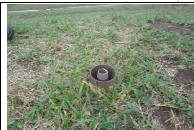
Foto 15 - Instrumento INA 05 sem tampa de proteção.
