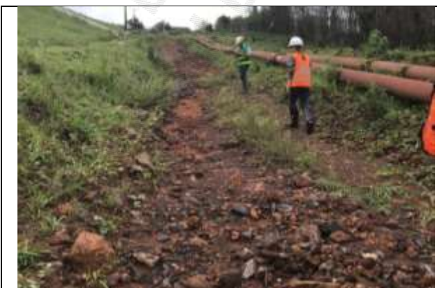
Foto 17 - Acesso na região do pé da barragem, pela ombreira direita, com erosões.
