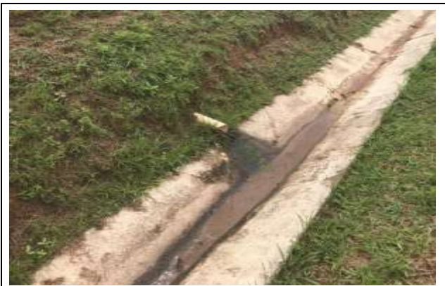
Foto 13 - DHP cujo fluxo é lançado diretamente sobre as canaletas de drenagem superficial.
