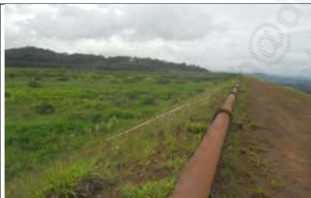
Foto 3 - Vista do talude de montante no sentido da ombreira esquerda e reservatório seco e com vegetação. Classificação quanto ao EC ("deterioração dos taludes/paramentos"): 0.
